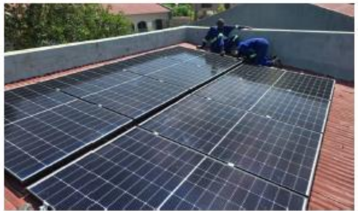
Installation du système solaire à l'école.
